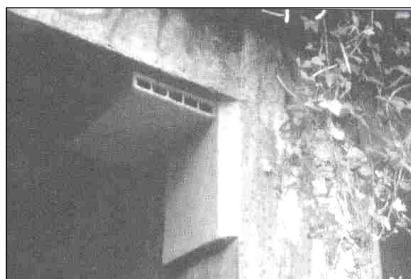
Photo1 : Gîtes artificiels en briques plâtrières creuses (Photo Philippe Penicaud in PENICAUD Philippe, Protéger les chauves-souris en milieu naturel et bâti, 1996)
